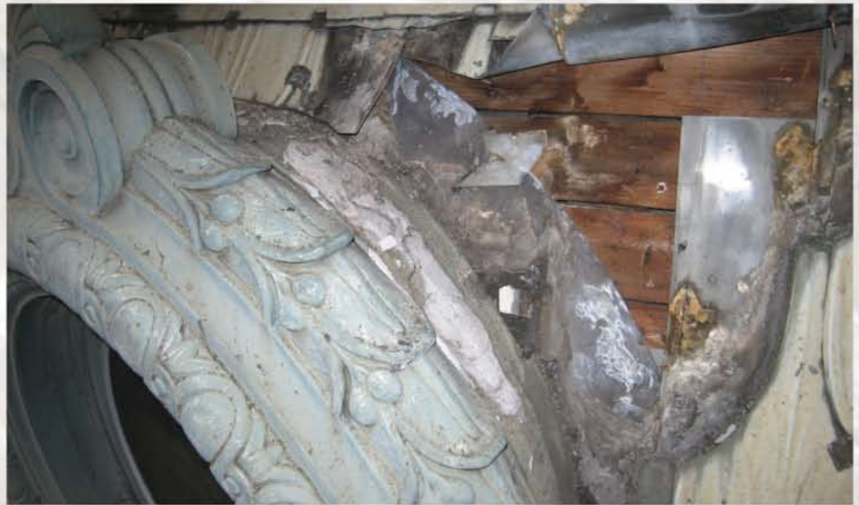
Nach der Demontage der alten Rundfenster kam eine weitestgehend gut erhaltene Holzunterkonstruktion zum Vorschein
